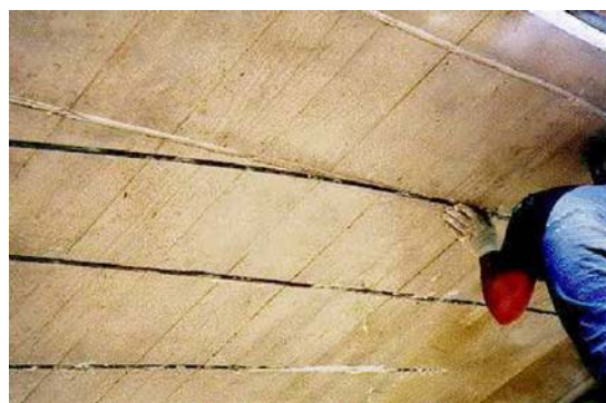
Obrázek 9-2: Zesilování desky uložením výztuže do drážky
